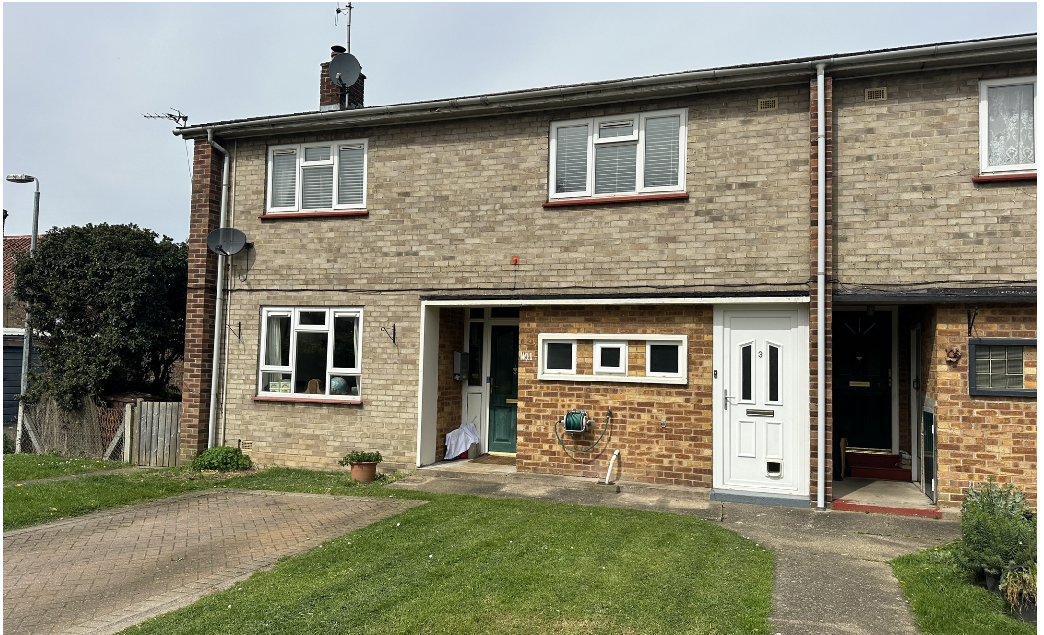
Mill Lane, Exning
